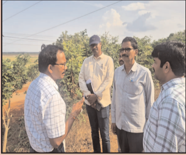
(షణ్ముఖ వెలుగు, ఉలవపాడు, మే 26) 33కేపీ తెట్టు ఫీడర్లో పాత కండక్టర్ మార్పిడి పనులను ఏపీసీపీడిసీఎల్ ప్రాజెక్ట్ డైరెక్టర్ డీవీఎస్ఎస్ మూర్తి మంగళవారం పరిశీలించారు. ఈ సందర్భంగా ఆయన మాట్లాడుతూ పనులు నాణ్యత ప్రమాణాలకు అనుగుణంగా నిర్వహించాలని అధికారులకు సూచించారు. విద్యుత్ సరఫరాలో అంతరాయాలు తగ్గించి వినియోగదారులకు మెరుగైన సేవలు అందించేందుకు ఈ పనులు కీలకమని తెలిపారు. పనులను వేగవంతంగా పూర్తి చేసి, భద్రతా ప్రమాణాలను కచ్చితంగా పాటించాలని అధికారులకు ఆదేశించారు. పనుల పురోగతి, సాంకేతిక అంశాల పై అధికారులను అడిగి తెలుసుకుని, అవసరమైన సూచనలు చేశారు. ఈ కార్యక్రమంలో సంబంధిత ఇంజనీర్లు, విద్యుత్ శాఖ అధికారులు పాల్గొన్నారు.
